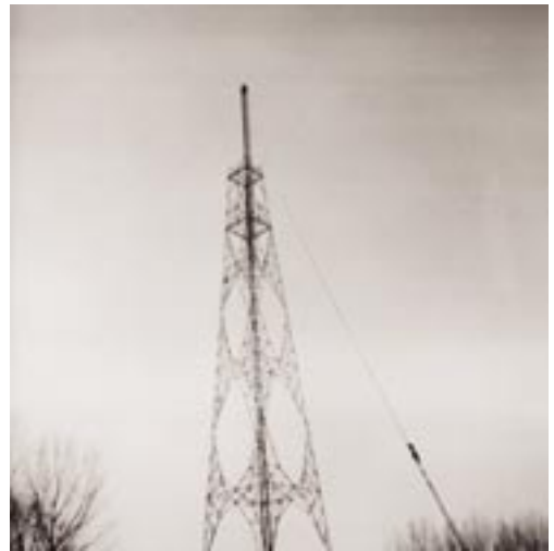
De hoogspanningsmast langs de Schelde tussen Buitenland en het Groot Schoor in opbouw (mei 1970).
