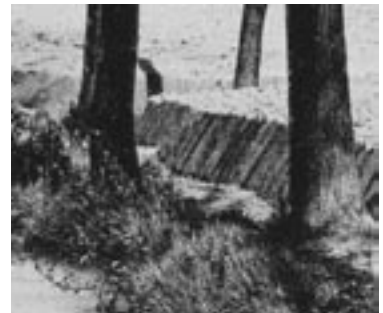
Detailopname van de sloten. [Massart 29]
