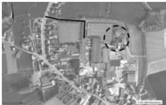
Luchtfoto met nieuwe weg en waterzuiveringsinstallatie bedrijf De Coster NV (2004). [GIS-Vlaanderen]
